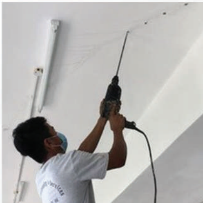
PU Injection Grouting
